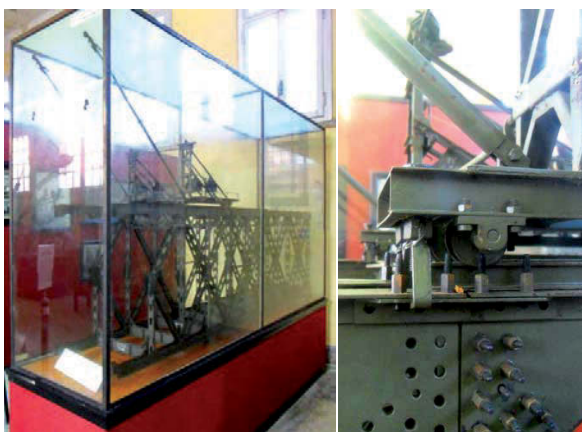
Foto 6 E 7. Modello di ponte metallico scomponibile tipo Roth Waagner austriaco (preda bellica), conservato presso l'ISGAG di Roma.
