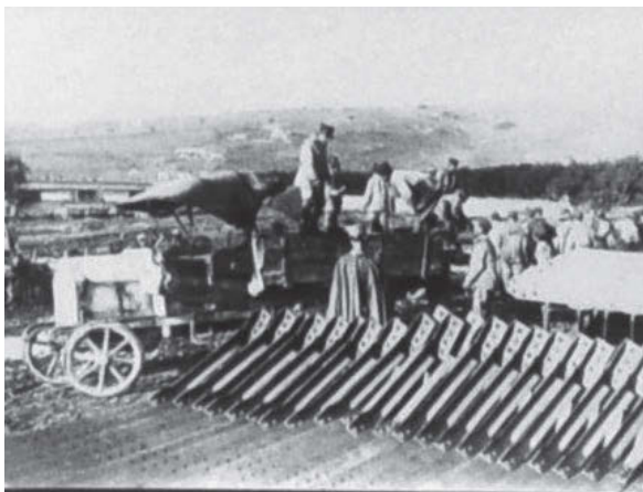
Foto 10. trasporto dei materiali R-W a piè d'opera presso Torrente S. Maria (Mascali-Riposto 1928).
