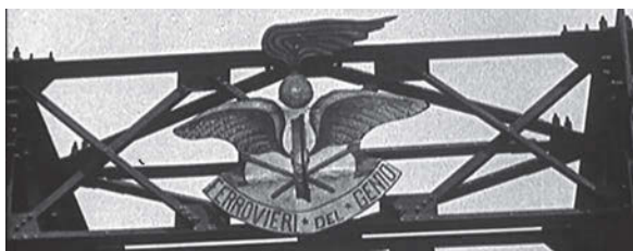
Foto 5. Lo stendardo del Genio Ferroviari, ubicato in prossimità della prima travata di controvento trasversale testata di un ponte Roth-Waagner, impiegato a Mascali.
