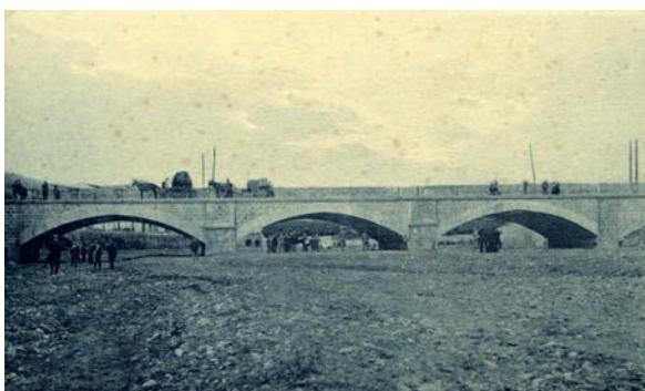
Foto 8 Ponte in pietra presso torrente Pietrafucile in località Carrabba (Mascali), distrutto dalla colata del 1928
