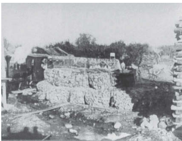
Foto 12. Vengono realizzate opere in difesa dei piloni centrali dalle piene .
